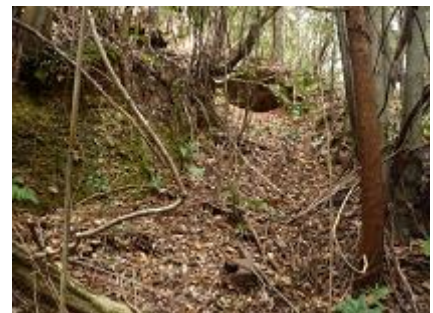
荒坂の貯蔵トンネル（手前が10mほど崩れて堀のようになっている）
